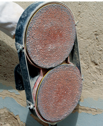
Aggressives Schleifen mit HMT-Schleifscheiben
