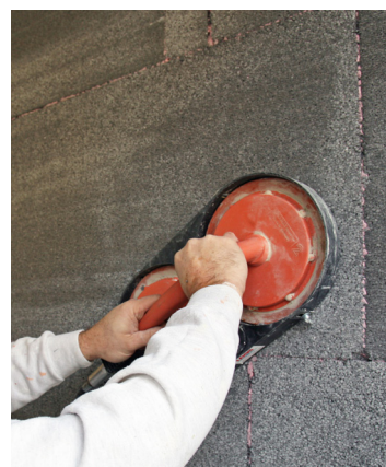
Vollwärmeschutzplatten planschleifen
